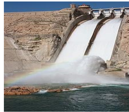
شکل ۲- سرریز اوجی سد مارون (الف)، مقطع هندسی سرریز اوجی (ب) Figure 2- Ogee weir of Marun dam (Arra, 2015) (a), and geometric section of Ogee weir (b)
